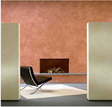
Abb. 13 moderne Spachteltechnik zur Gestaltung von Innenräumen 88
